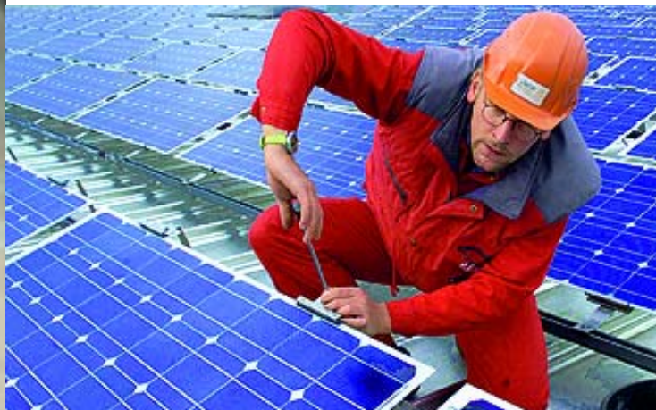
Ein Monteur verschraubt Solarpanels auf einem Dach. Die Förderung von erneuerbaren Energien im Hausbau schafft sichere Arbeitsplätze.
